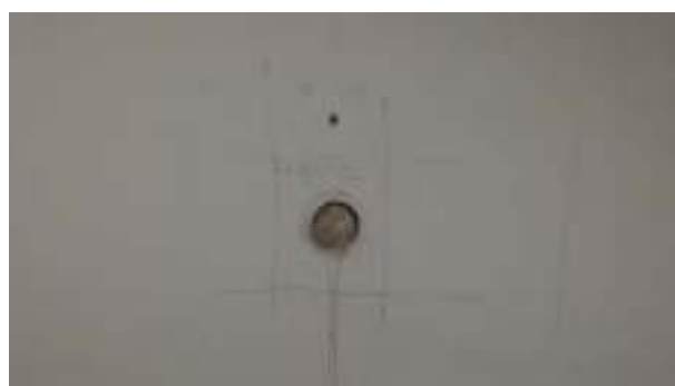
fig. 20 indagini pacometriche e carotaggi setto piano rialzato corpo 1
