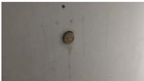
fig. 19 indagini pacometriche e carotaggi vano ascensore piano secondo corpo 1
