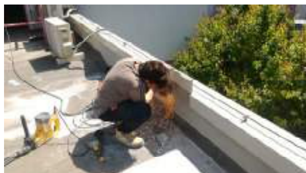
fig. 30 indagini prelevamento barre di armatura e carotaggi piano secondo
